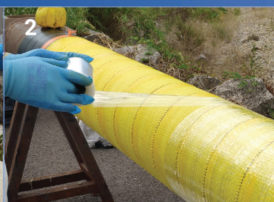
2 Instalación de la película de compresión
